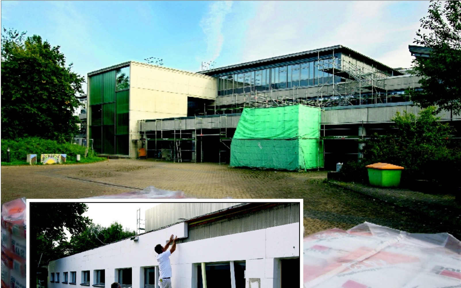
Das Schlossgymnasium hat sein Aussehen stark verändert: Zum einen gibt es den neuen Treppenturm am Eingang und acht neue Klassenzimmer im zweiten Stock, zum anderen bekommt die Fassade nach der energetischen Sanierung einen neuen „zeitgemäßen“ Anstrich in Grau. Das kleine Bild links zeigt Wärmedämmarbeiten an der Walter-Jacob-Halle, der Sporthalle des Schlossgymnasiums. Fotos: Jean-Luc Jacques
