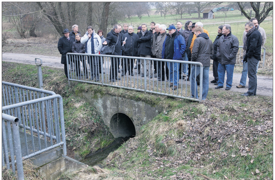
Vor-Ort-Termin am Ötlinger Dupiggraben: Wenn's regnet, geht's an dieser Stelle schnell eng zu.
